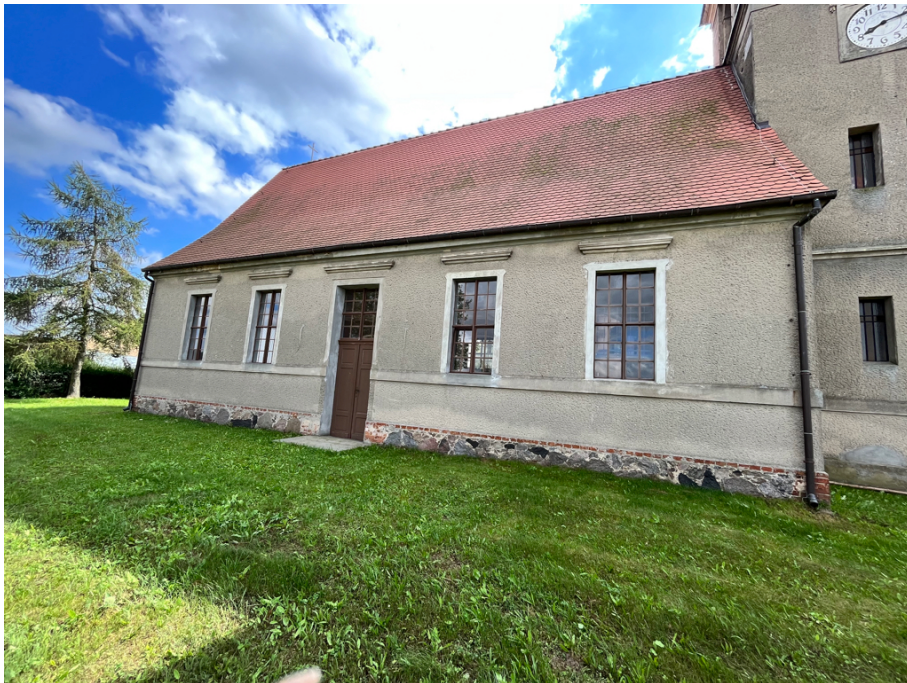
Fot. 5. Elewacja północna kościoła, aktualny stan zachowania.
