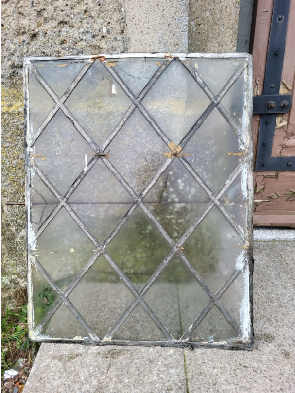
Fot. 14. Pierwotna, zdemontowana konstrukcja witraża wieży.
