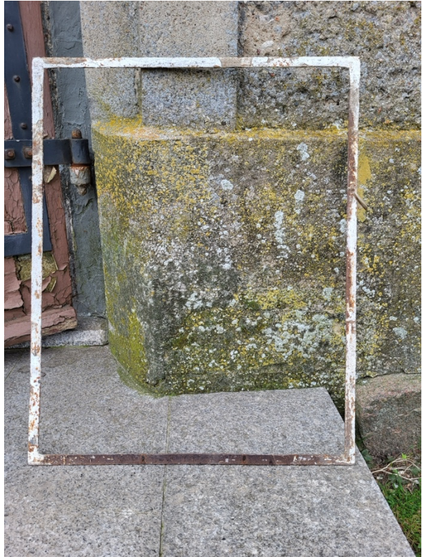
Fot. 15. Stalowa rama konstrukcji witraża
