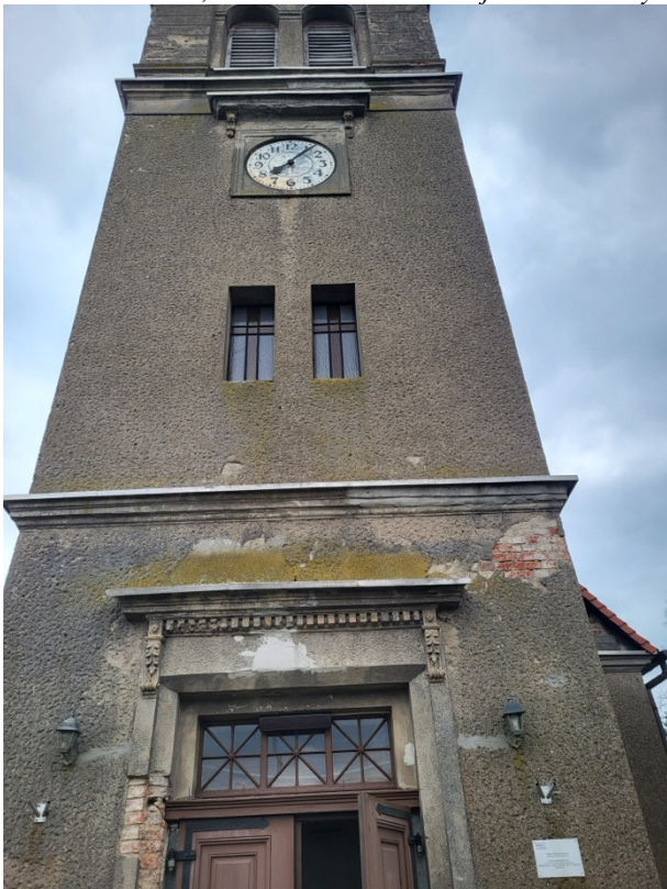
Fot. 16. Zachodnia elewacji wieży - aktualny stan zachowania. Widoczna wtórna stolarka okienna
