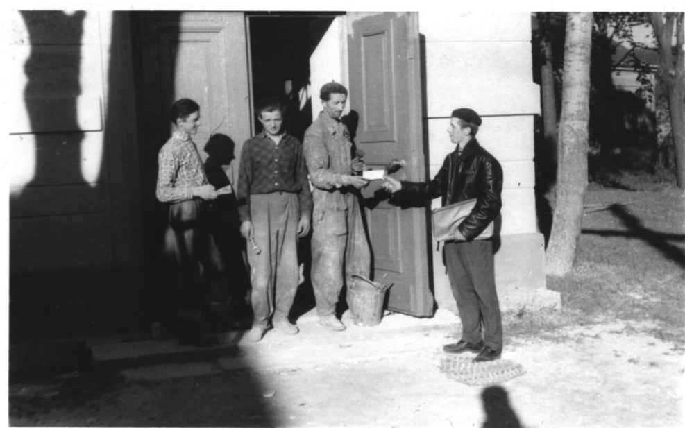
Fot. 3. Dolne partie elewacji zachodniej wieży, w obrębie głównego wejścia, ujęcie wykonane w latach XX wieku. Widoczna zróżnicowana szerokość boniowania.
